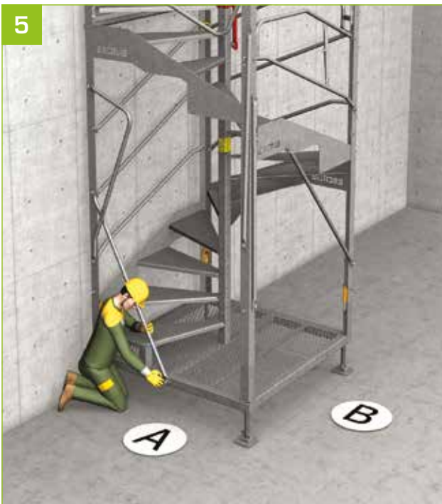
- An den Zugängen die Geländerstreben positionieren, dabei den Hauptzugang vorzugsweise auf der Seite A vorsehen (die Seiten sind mit Aufklebern gekennzeichnet).
